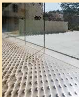
三保谷硝子店による波板ガラスを使った渡り廊下には、陽光が差し込む角度によって、ハート型の影が現れる
