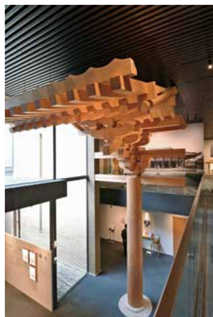
7メートルを超える高さでそびえ立つ原寸大の唐招提寺金堂の柱と組物など、最高の職人技を詰め込んだ特別な模型を展示
