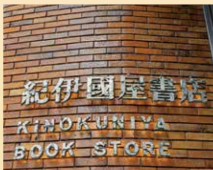
前川建築の特徴である「打ち込みタイル」が施されている外観の壁面
