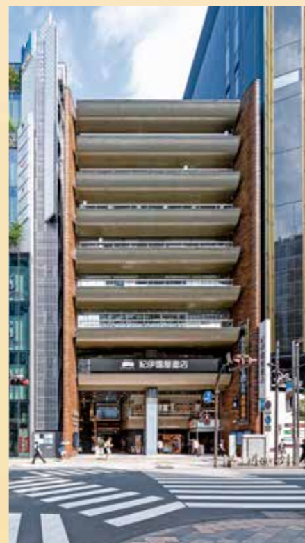
紀伊國屋ビルディング（東京都新宿区） （撮影：株式会社エスエス）
