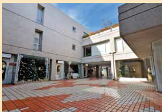
昭和48年（1973）に竣工した2期・C棟の中庭
