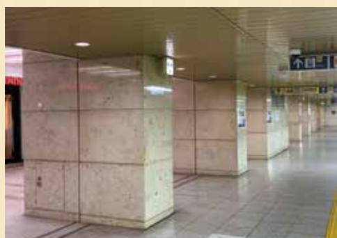
ジュライエローの柱が並ぶ東京外口銀座線三越前駅中央改札前の通路
