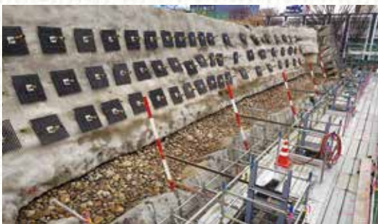
石垣修復工事の様子。築石の裏側に円礫(栗石)を敷き詰めて固定しながら積み直していく(写真提供:盛岡市役所 公園みどり課)
