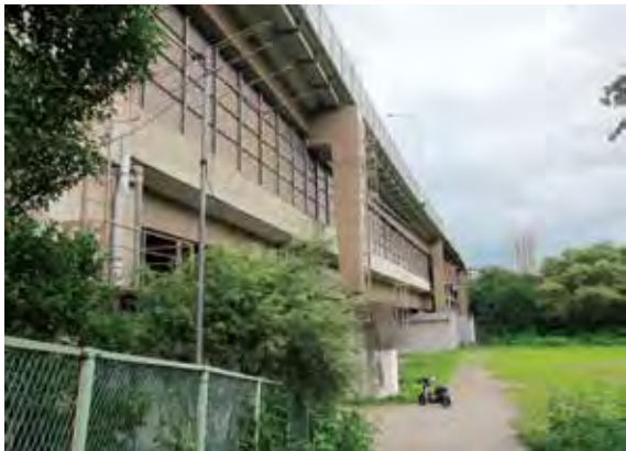
上下二層の道路橋となっている現在の仲の瀬橋(宮城県仙台市青葉区)
