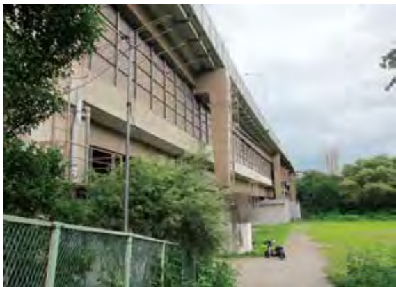
上下二層の道路橋となっている現在の仲の瀬橋(宮城県仙台市青葉区)
