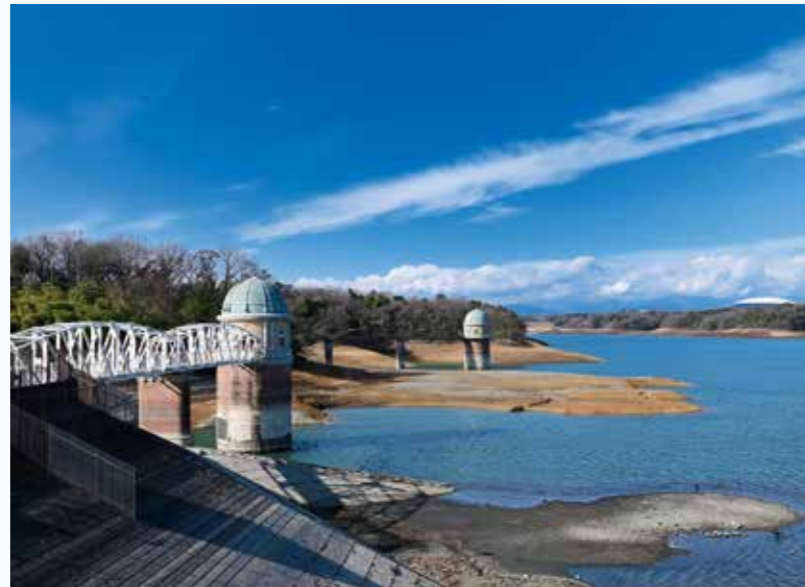
村山下貯水池第一取水塔(1925年竣工 東京都東大和市)
