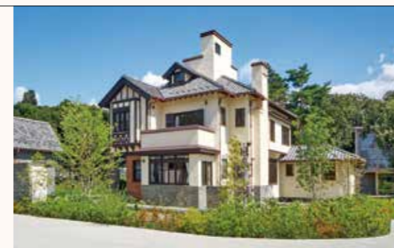
渡辺基吉邸(茨城県取手市) (写真提供:前田建設工業株式会社)
