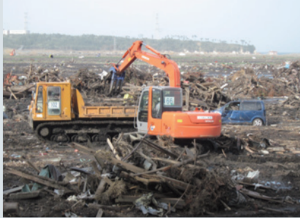
南相馬市 がれき撤去作業 (写真提供：一般社団法人福島県建設業協会)
