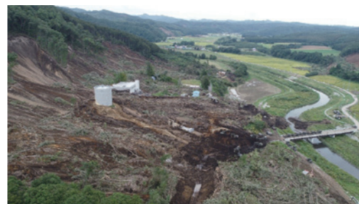
北海道胆振東部地震では、厚真町を中心とした広い範囲で土砂崩れが発生した (写真提供：一般社団法人北海道建設業協会)
