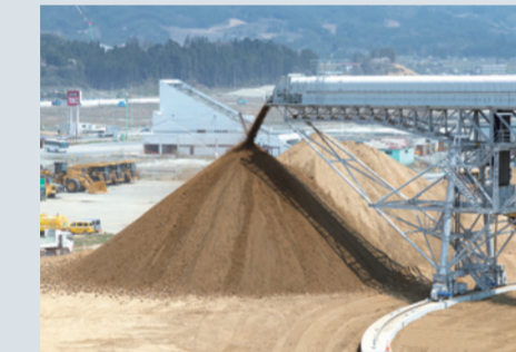
陸前高田市震災復興事業におけるベルトコンベヤによる土砂搬送 (写真提供：清水建設株式会社)
