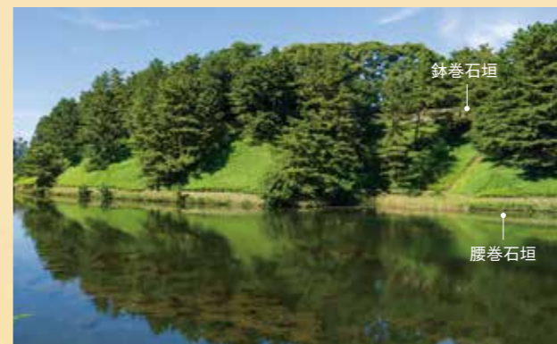
桜田堀の3段構造の土塁式石垣
