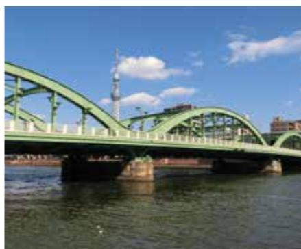
蕨橋(1929年竣工) 設計:谷井陽之助他
