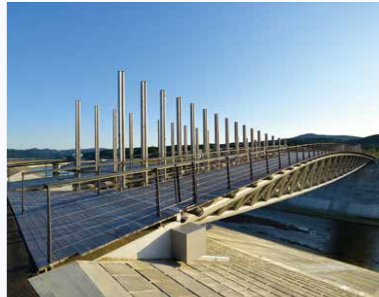
中橋(トラス橋 2020年竣工 宮城県南三陸町)
