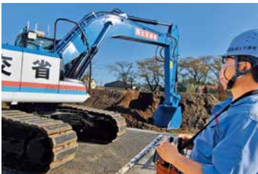
特定小電力無線を活用した無人化施工実習 (写真提供：国土交通省 関東地方整備局 関東技術事務所)
