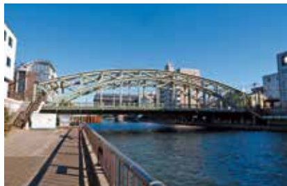
現在の万年橋は、アーチ部分だけトラス構造で組み立てる「プレストリブタイドアーチ橋」という構造
