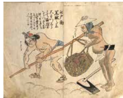
図1:天保14年(1843)の印旛沼開削工事における黒鍬の図(酒田市立光丘文庫所蔵(寄託)/光丘文庫デジタルアーカイブ 続保定記1巻116コマ目より転載) もっこで七十貫(約262kg)もの土を担いだと書かれている
