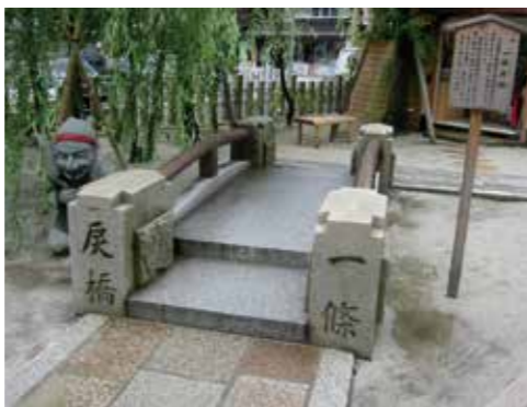
一條辰橋(京都市上京区 晴明神社内)。平成7年(1995)まで実際に使用されていた。安倍晴明はこの橋の下に式神を隠していたという(2004年撮影)
