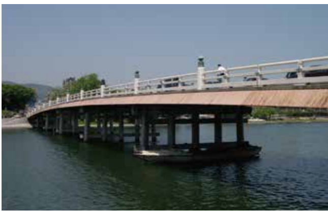
瀬田唐橋(滋賀県大津市)
