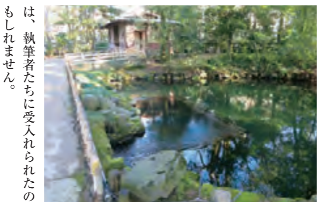
兼六園の辰巳用水沈砂池。辰巳用水の水はここで砂を落として園内に引き入れる(石川県金沢市)
