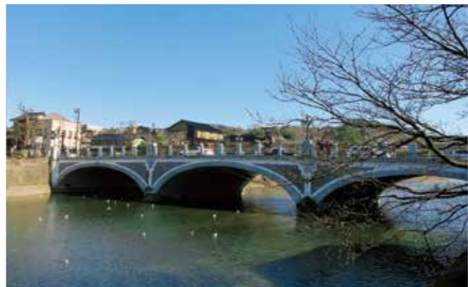
浅野川に架かる金沢を代表する橋「浅野川大橋」(石川県金沢市)
