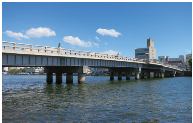
松江大橋 手前が事故現場となった第一号橋脚（島根県松江市）
