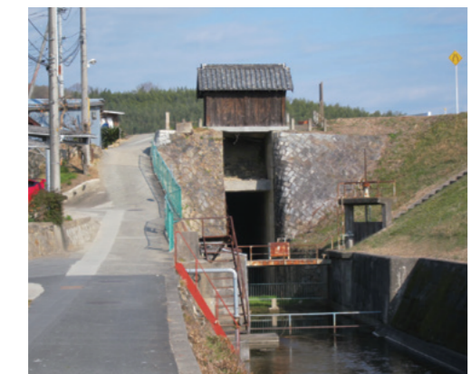
高瀬通しの一ノ口水門
