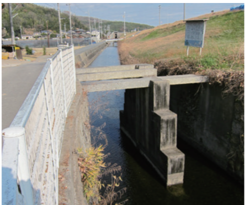
高瀬通しの二ノ口水門
