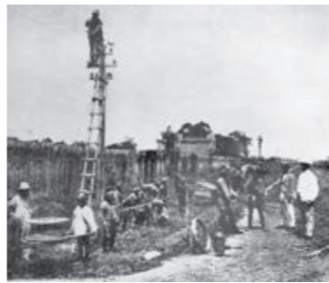
大森付近の電信架設工事
