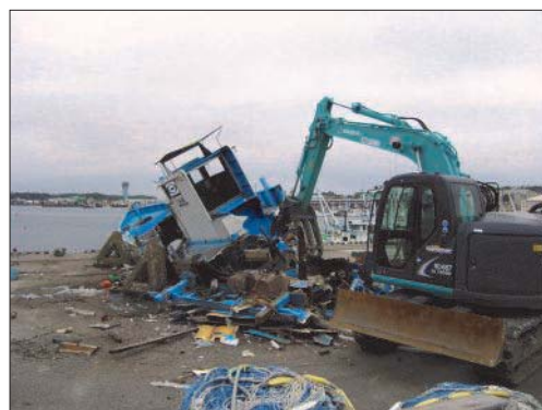
津波で陸揚げし大破した漁船の処理
