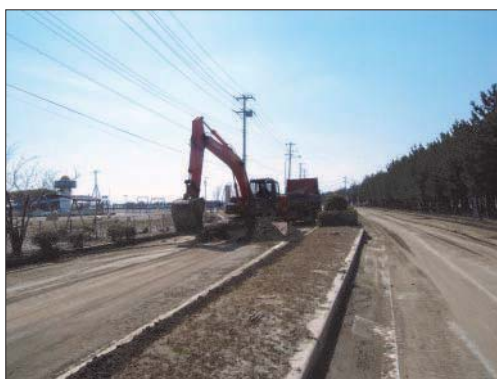
津波により道路にたまった泥を取り除く
