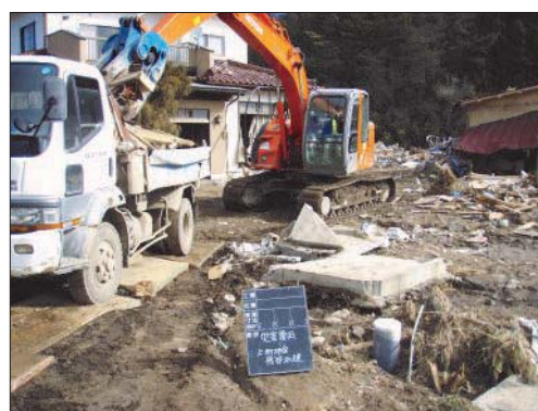
瓦礫撤去作業
