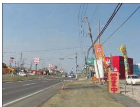
液状化で傾いた看板や電柱
