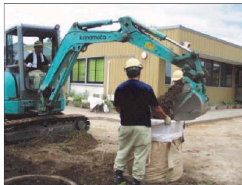
汚染土の回収
