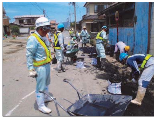
側溝の土砂上げ
