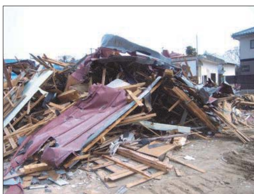
鉄砲水で倒壊した家屋
