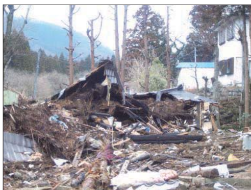
鉄砲水で倒壊した家屋
