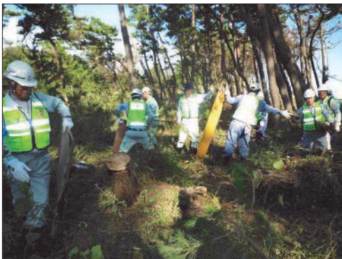
枯れた松の伐採作業
