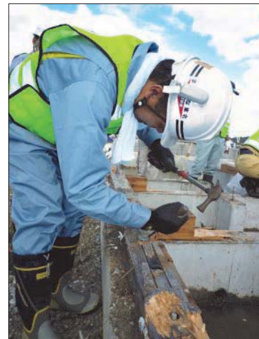
ボルトの取り外しに苦勞する
