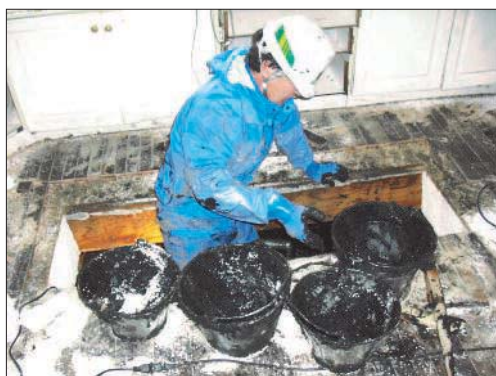
床下の泥上げ
