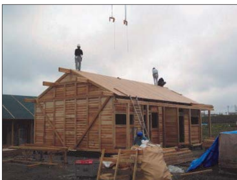
県産材を使った仮設住宅建設
