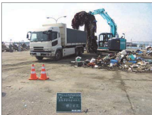
漁港の瓦礫撤去
