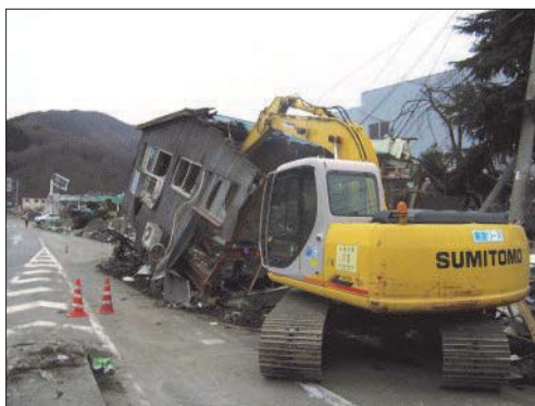
釜石市内での瓦礫撤去
