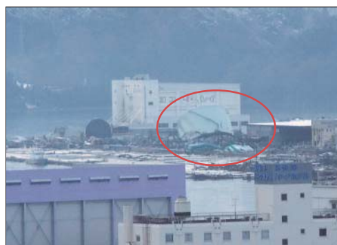
流されて来た石油タンク
