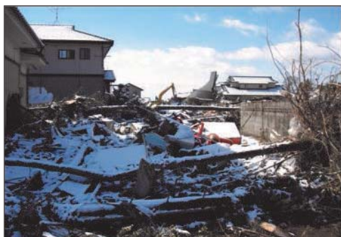
震災直後、道路啓開前（若林区）
