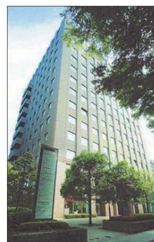
橋本店 本社ビル
