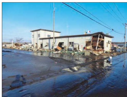
被災後の港湾漁港部
