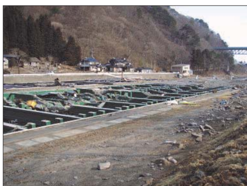
破損したふ化施設
