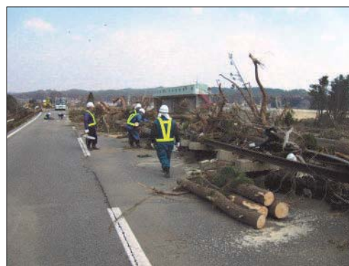
枕木が付いたレールが流れ着いている国道
