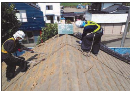
屋根の解体作業
