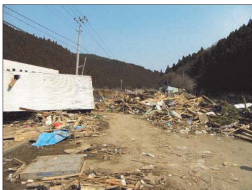
国道45号線瓦礫撤去着工前
