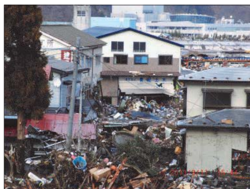
津波が引いた直後の本社事務所付近
