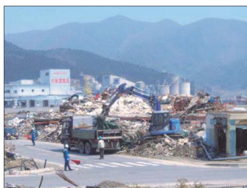
大船渡市内の瓦礫撤去の様子
