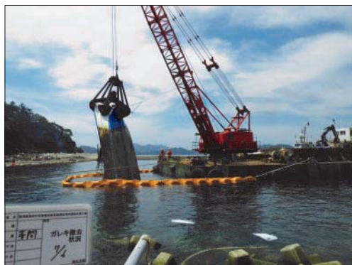
港湾での瓦礫撤去
