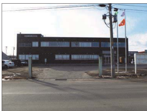
新築された事務所
