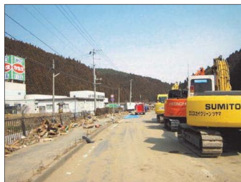
国道45号線瓦礫撤去完了後
