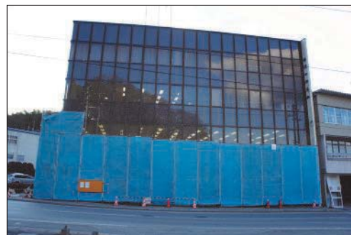
小野良組 本社（1～2階は補修作業中）
