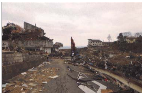
国道45号線の啓開作業
