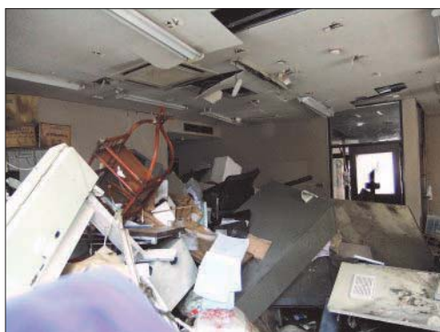
浸水した本社1階部分
