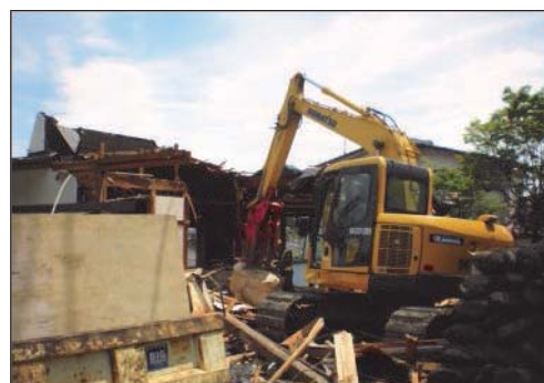
重機を使っでの解体撤去
