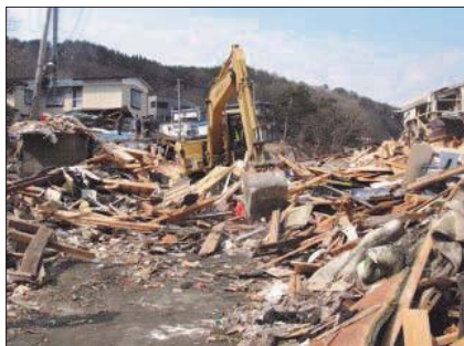
元の街並みが分からないほどの瓦礫を撤去していく
