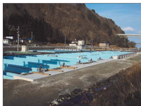
修繕が完了したふ化施設
