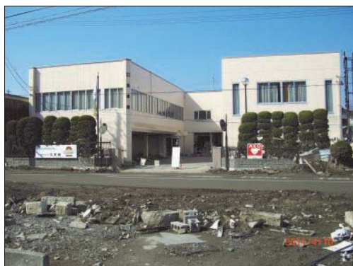
津波により被災した本社
