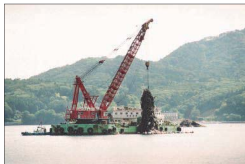
海中の瓦礫撤去
