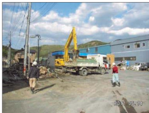
市街地での瓦礫撤去
