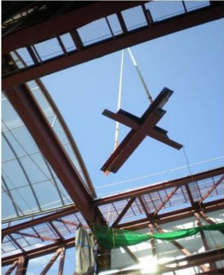
タワークレーンで梁を吊ってくると、屋根養生が一部開く。
