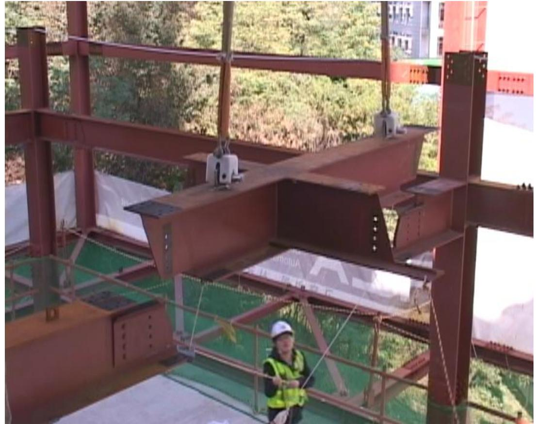
梁のくさびに付けたガイド用ワイヤをブラケットのくさび受け穴に通し、引っ張って位置決めする。
