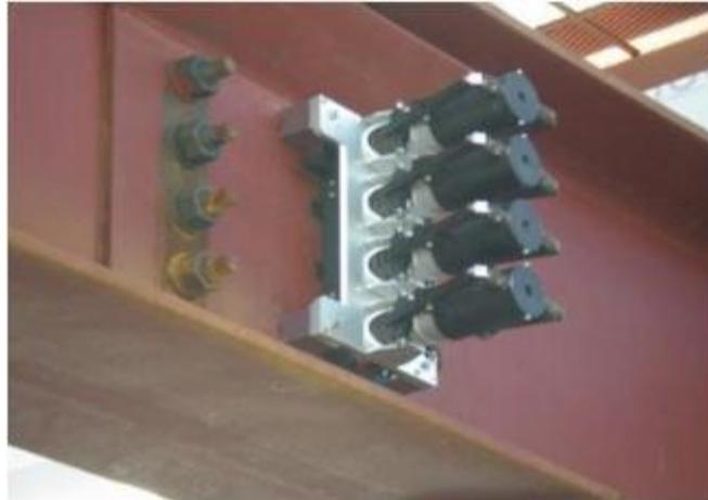
ボルトユニットが取り付けられた状態。ボルトが4本挿入されている。
